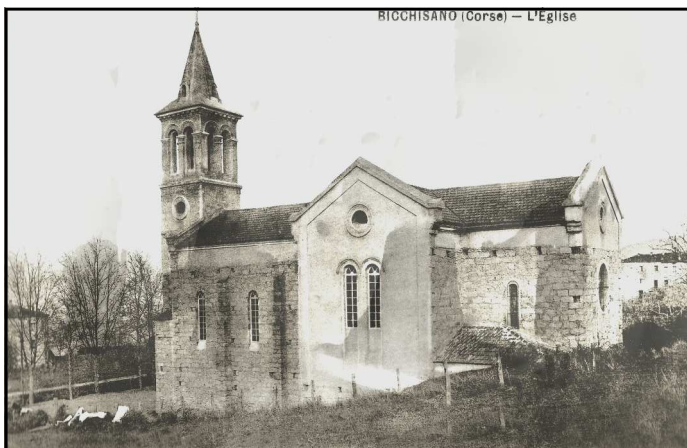
Eglise de l'Anunziata avant le crépissage des façades
